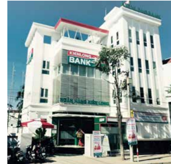
PGD Vĩnh Hải: Số 420 đường 2/4, P. Vĩnh Hải, Tp. Nha Trang, T. Khánh Hòa
